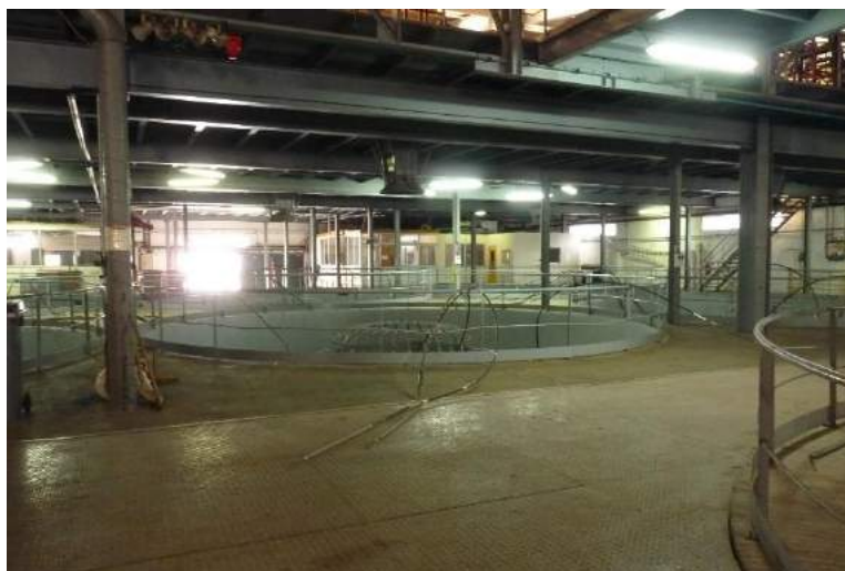
Stockage de réserve d'un câble sous-marin.
