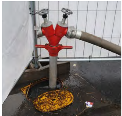
Trappe de borne incendie - cette typologie peut nécessiter la mise en place d'un dispositif en Y ou T pour laisser un raccordement de protection incendie libre (selon les souhaits du SDIS)
