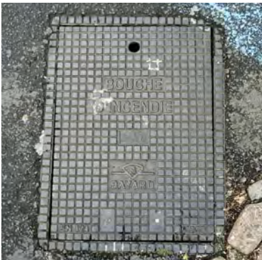
Trappe de borne incendie - cette typologie peut nécessiter la mise en place d'un dispositif en Y ou T pour laisser un raccordement de protection incendie libre (selon les souhaits du SDIS)
