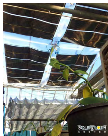
Ecran d'occultation photovoltaïque pour serres
