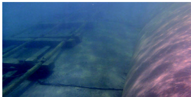
Prototype de brise lame immergé connecté au dispositif développé par GEOCORAIL SAS
