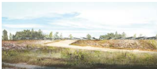
Centrale solaire thermique NEWHEAT sur le site de la papeterie de Condat (24)
