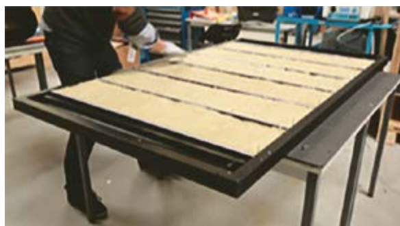
Fabrication du module DualSun étape de pose des isolants
